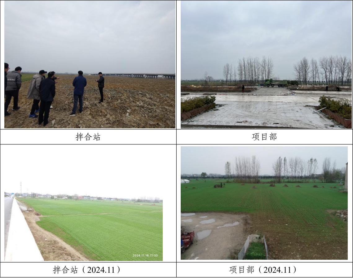
施工场地防治区目前现状见图 1.1-7。
